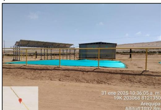
FOTOS N°3: 14 PANELES SOLARES INSTALADOS SOBRE ESTRUCTURA METALICA DEL MODULO- 1. IDENTIFICADO COMPONENTE
